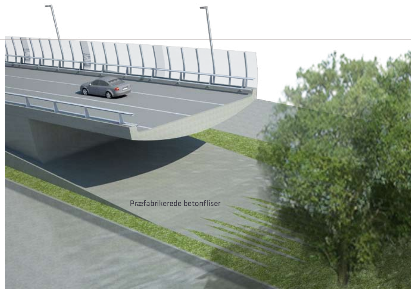
Eksempel på behandling af overflader under broer og i midterrabbatter. Specialfremstillede betonfliser fletter sammen med græsarealerne.
